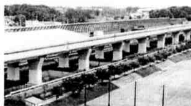
写真4 マンションの東側の防音壁
