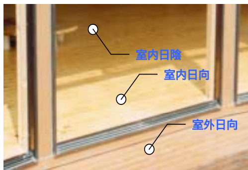
写真1 ホールの床表面温度の計測点位置
